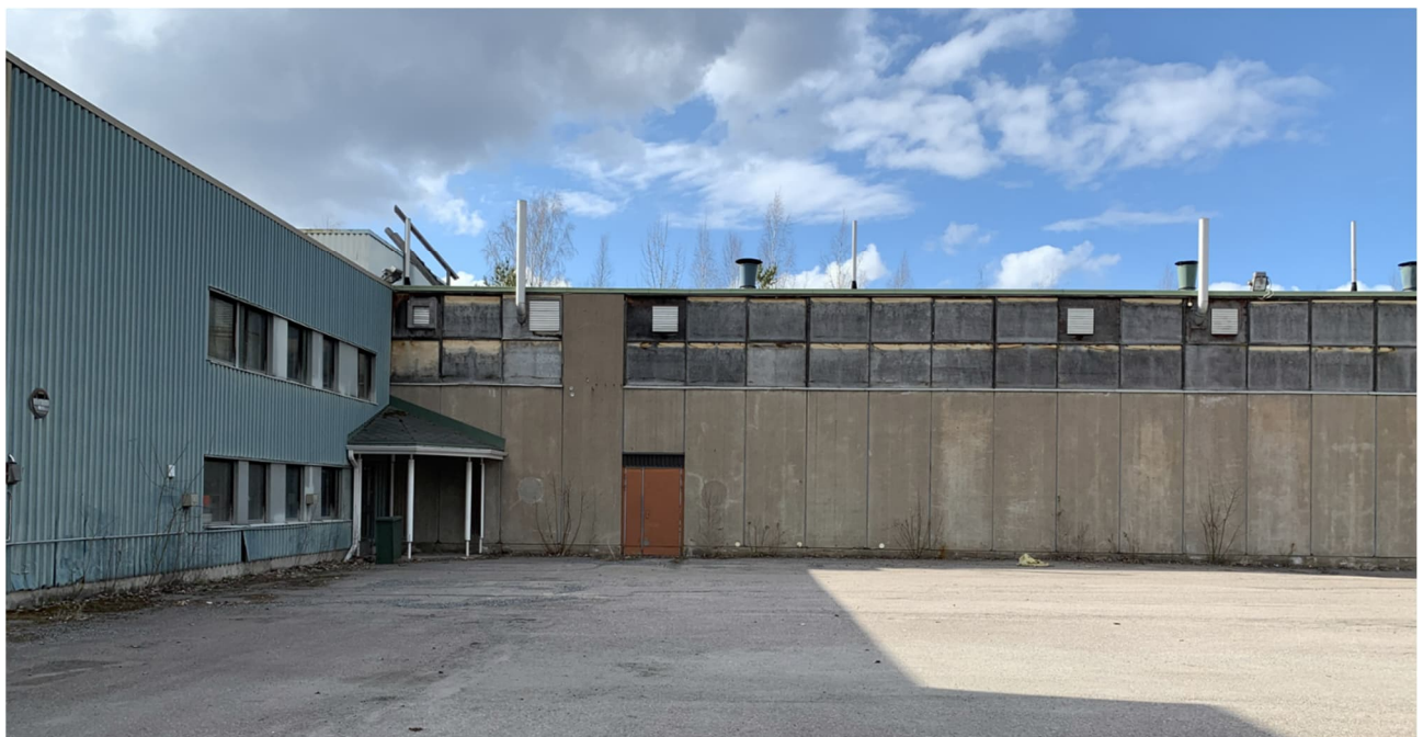
Eri ikäisiä rakennuksen osia sisäpihalta kuvattuna. Vasemmalla uudempi vuoden 1974 laajennus. Valokuva: © Tampereen kaupunki 28.2.2024
